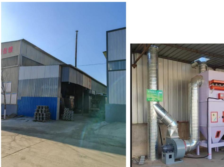
图 3-1 项目铸造车间布袋除尘器 15m 排气筒照片
